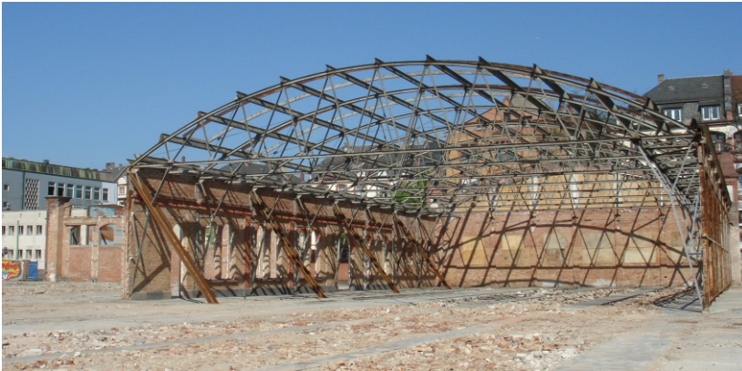
Das entkernte Depot im April 2007 während der Sanierung und Restaurierung
