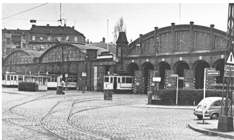
Die drei Hallen des Straßenbahndepots in den 1960er Jahren
